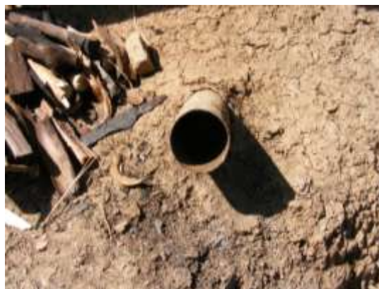
ภาพผนวกที่ 14 ช่องใส่ไฟ และเติมฟืน สำหรับ ปรับความร้อนภายในเตา
