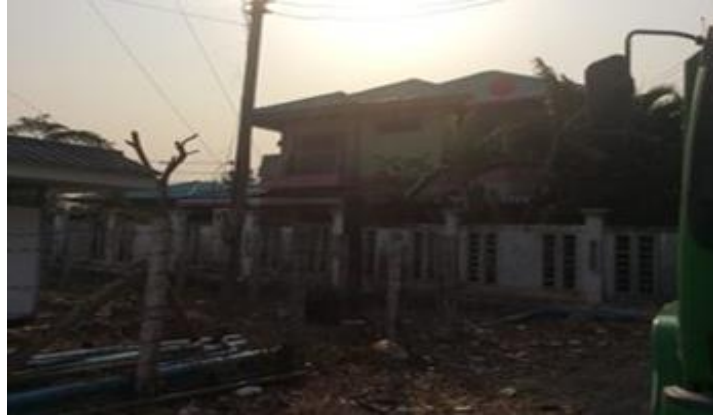
ภาพที่ 3.34 ทศนียภาพทางด้านทิศตะวันตก
