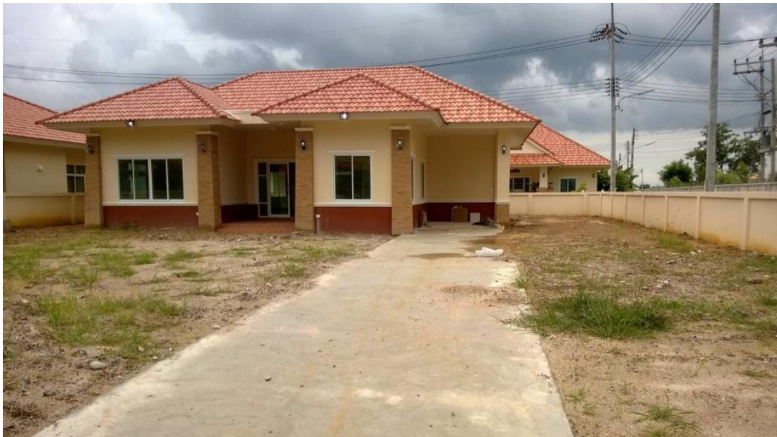
ภาพที่ 1.2 ทิศเหนือติดกับถนนโครงการ
