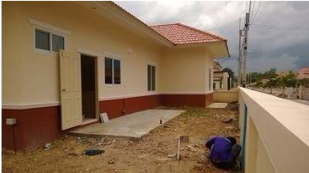
ภาพที่ 1.4 ทิศใต้ติดกับถนนโครงการ
