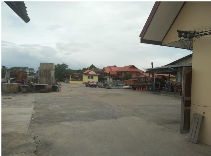
ภาพที่ 3.47 มุมมองภายในโครงการด้านทิศเหนือ
