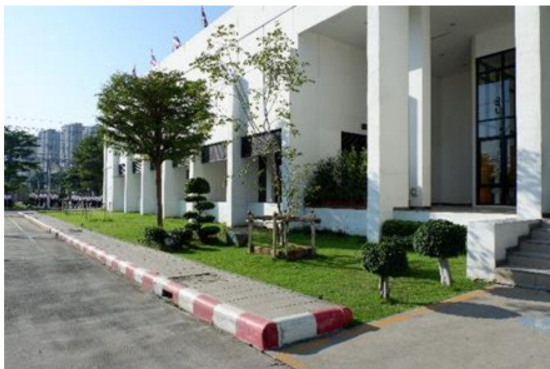
ภาพที่ 3.17 ระบบระบายน้ำ
