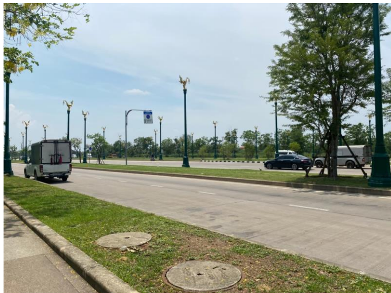
ภาพที่ 3.8 ระบบระบายน้ำ
