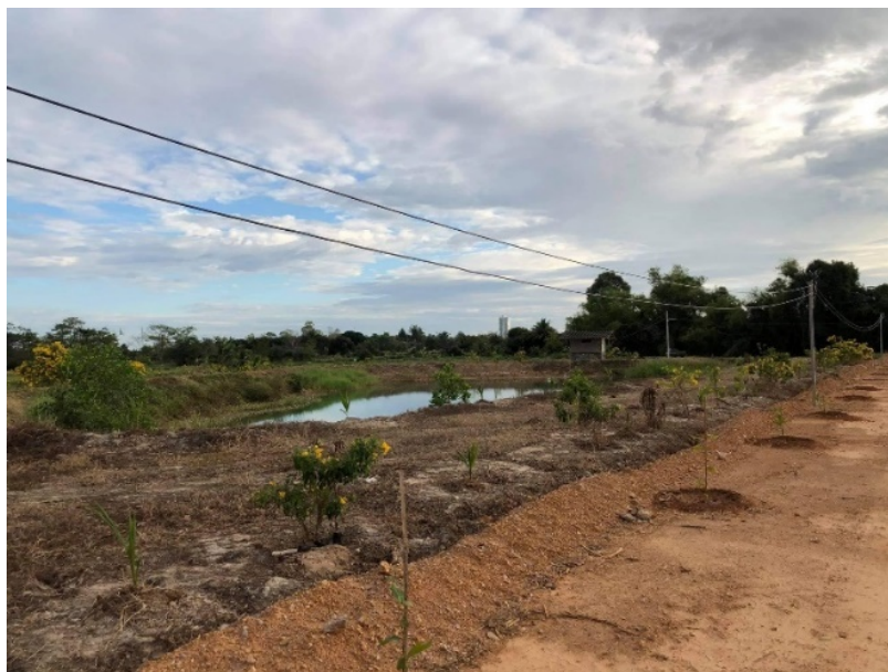
ภาพที่ 3.17 ระบบไฟฟ้าในโครงการ
