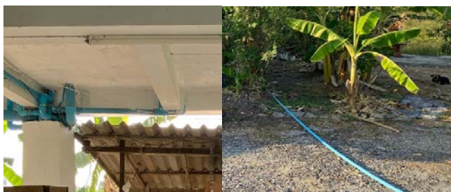
ภาพที่ 3.14 แหล่งน้ำประปาที่นำมาใช้ในโครงการ
