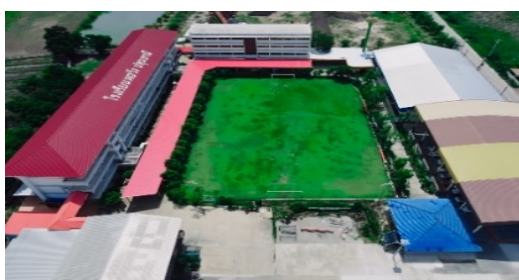
ภาพที่ 2.13 บริเวณรอบอาคารที่เป็นพื้นซีเมนต์
