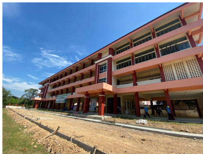
ภาพที่ 3.19 อาคารเรียนเรียนเสริม รูปแบบอาคารเป็นอาคารเรียน คสล. 4 ชั้น
