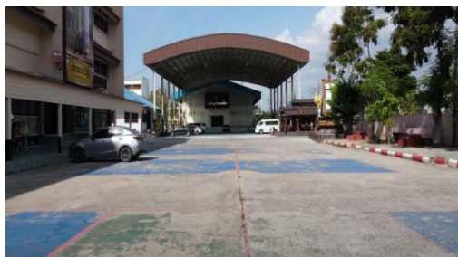
ภาพที่ 2.4 บริเวณรอบอาคารที่เป็นพื้นซีเมนต์
