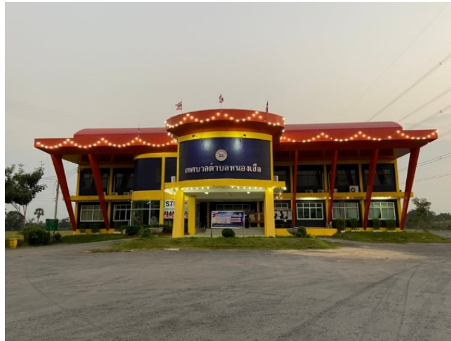
ภาพที่ 3.11 อาคารสำนักงานเทศบาลเดิม มีขนาดพื้นที่ 771.67 ตารางเมตร
