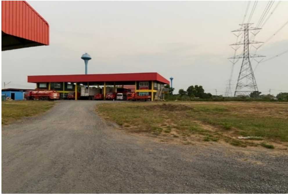
ภาพที่ 3.25 พื้นที่อาคารจอดรถสาธารณะ (รถดับเพลิง) เดิมทิศใต้
