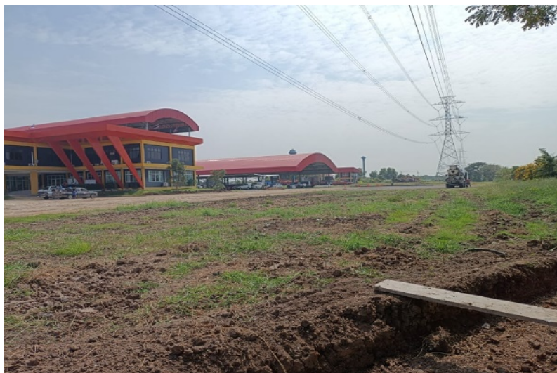
ภาพที่ 3.27 มุมมองที่มองจากภายนอกสู่ภายใน ด้านทิศตะวันตกเฉียงเหนือ
