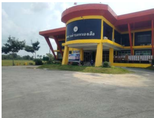
ภาพที่ 3.22 พื้นที่ลานจอดรถฝั่งหน้าอาคารทิศเหนือติดเส้นทางหลัก ถนนพท.4001
