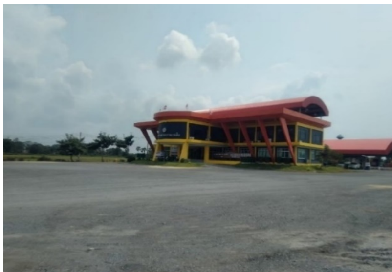
ภาพที่ 3.28 มุมมองที่มองจากภายนอกสู่ภายใน ด้านทิศตะวันตกเฉียงเหนือ
