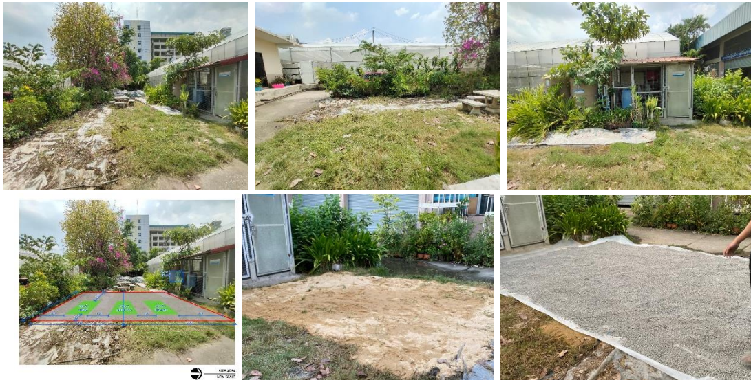
ขั้นตอนที่ 1 ปรับพื้นที่ ถอนหญ้า นำทรายมาเท นำพลาสติกมาปูทับทราย เทหินเกล็ดลงบนแผ่นพลาสติกเพื่อปรับระดับ
