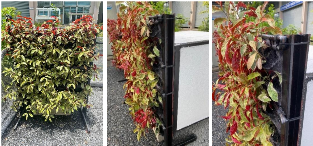
ภาพที่ 3.2 การติดตั้งสวนแนวตั้งแบบ Living Wall (Felt Layer) บริเวณพื้นที่ทดลอง
