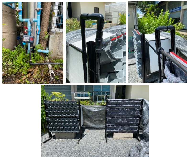
ขั้นตอนที่ 3 ติดระบบน้ำบนแผงสวนแนวตั้ง
