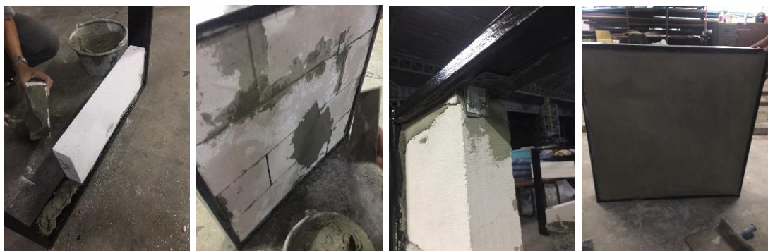
ขั้นตอนที่ 4 ด้านที่ใช้ทดลองใช้เหล็กเป็นโครงสร้างและก่ออิฐมวลเบาฉาบด้วยปูนซีเมนต์
