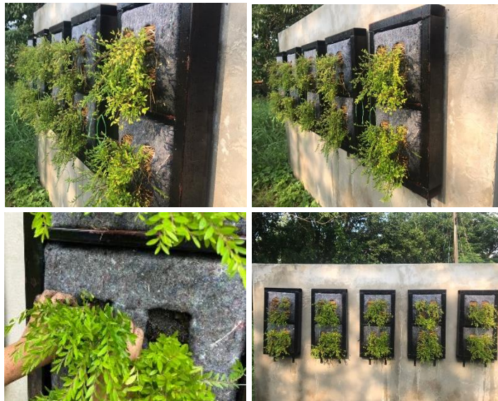
ภาพที่ 2 ใส่แผ่นปลูกพืชลงไปกรอบแผ่นปลูกพืช และทำการปลูกพรรณไม้บนแผ่นปลูกพืชสวนแนวตั้ง
