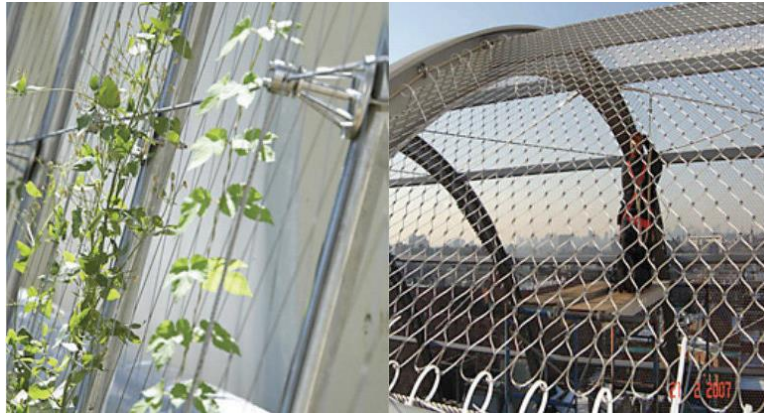
ภาพที่ 2.3 แผงระบบกริดและระบบสายเชือก
