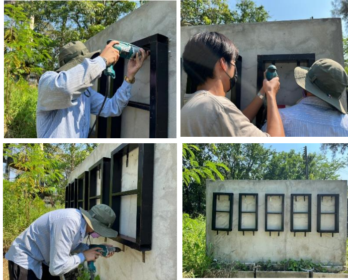
ภาพที่ 1 ติดตั้งกรอบแผ่นปลูกพืชบนผนังกำแพง
