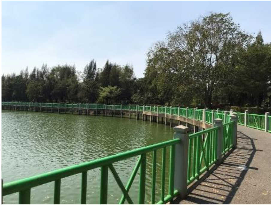
ภาพที่ 3.3 สิ่งก่อสร้างเดิม สะพาน
