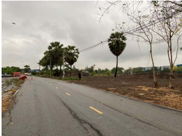
ภาพที่ 3.14 ระบบไฟฟ้าภายในโครงการ
