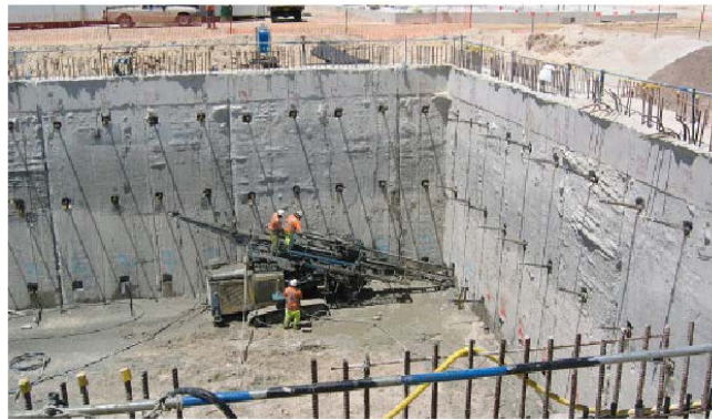
ภาพที่ 2.14 กำแพงกันดินแบบ Diaphragm wall
