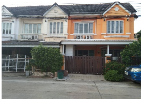
ภาพที่ 1.5 อาณาเขตติดต่อทางทิศเหนือ ติดกับถนนภายในหมู่บ้าน
