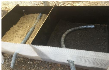
ภาพที่ 3.16 ขุดร่องเพื่อวางท่อระบายน้ำ รูปแบบที่ 3
