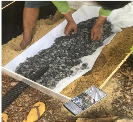
ภาพที่ 3.12 นำหินกรวดใส่ลงไปในพื้นที่เตรียมไว้ รูปแบบที่ 2
