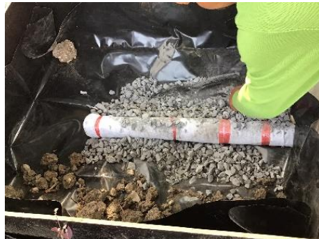
ภาพที่ 3.6 นำหินกรวดลงไว้ก้นหลุม รูปแบบที่ 1
