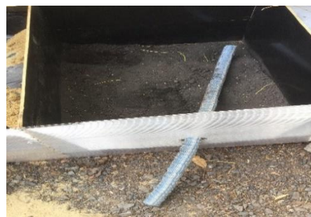
ภาพที่ 3.17 นำท่อสับซอยหรือท่อระบายน้ำแบบสปริงมาวางในร่องที่เตรียมไว้ รูปแบบที่ 3
