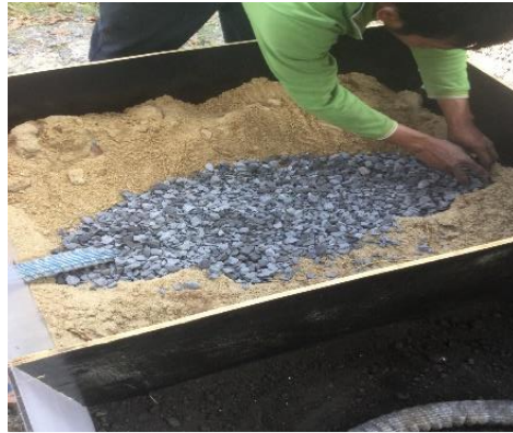
ภาพที่ 3.19 นำหินกรวดมาใส่ในหลุมให้เต็ม
