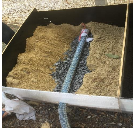
ภาพที่ 3.18 นำหินกรวดมารองก้นหลุมเพื่อปรับระดับ
