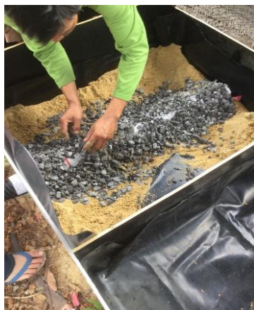
ภาพที่ 3.7 นำหินกรวดมาใส่ในหลุมให้เต็ม รูปแบบที่ 1
